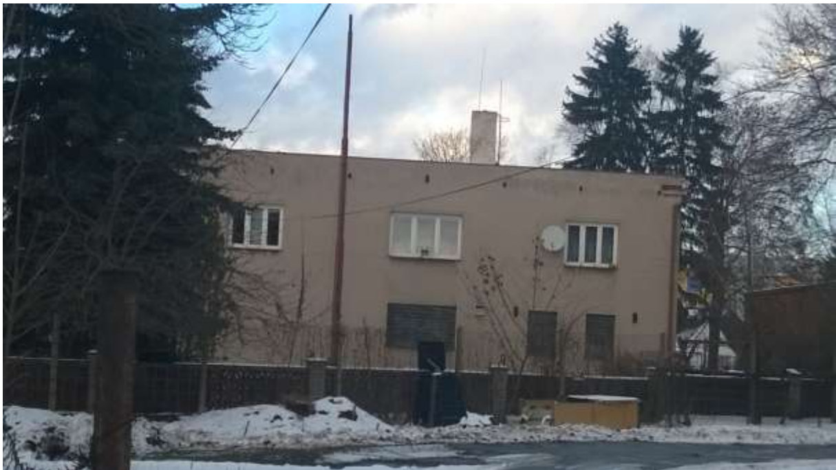
Hasičská zbrojnice čp.81
